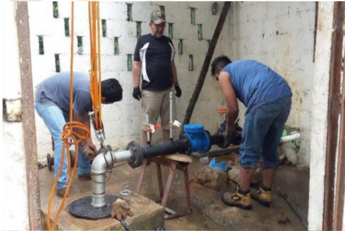
Sustitución de válvulas de descarga de agua
